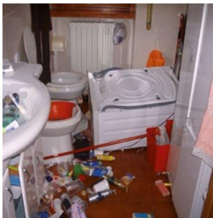
Interno di una bagno dopo il **terremoto di L'Aquila del 6 Aprile 2009, Magnitudo=6.3**. L'azione sismica è stata tale da produrre il ribaltamento della lavatrice.
