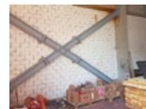
Esempio di intervento di rinforzo su edificio in cemento armato. La croce (controvento) d'acciaio aumenta la resistenza della struttura all'azione sismica.
